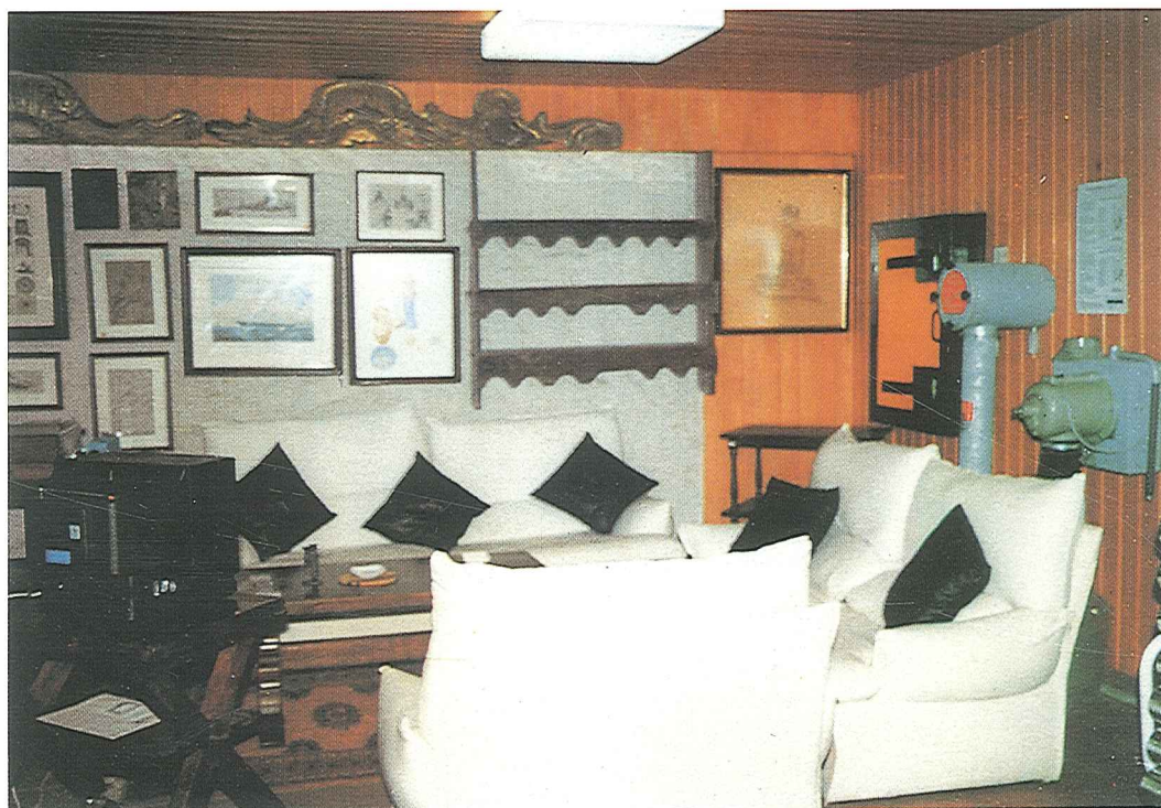
Refugio antiatómico unifamiliar. Al fondo, salida de emergencia y sistema de filtros.
