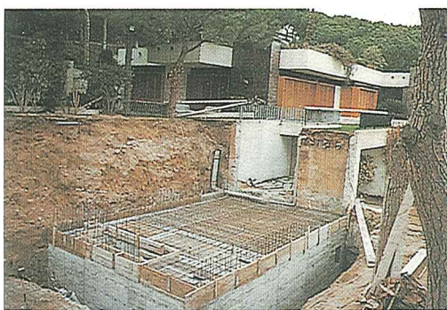
Construcción de un refugio unifamiliar adosado a un chalet. 300 toneladas de hormigón armado.
