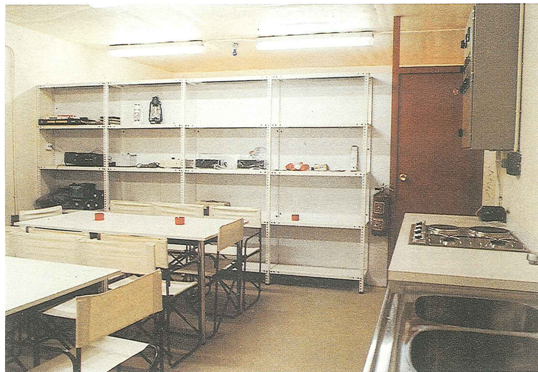
Distribución funcional de un refugio. Sala de estar, cocina, cuadro eléctrico y, al fondo, dormitorios con luz azul de noche.
